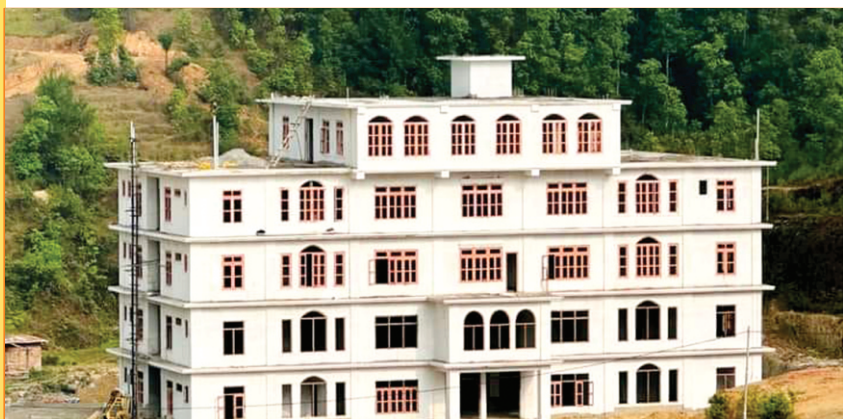
रुक्षेत्र गाउँपालिकाको निर्माणाधीन प्रशासनिक भवन
