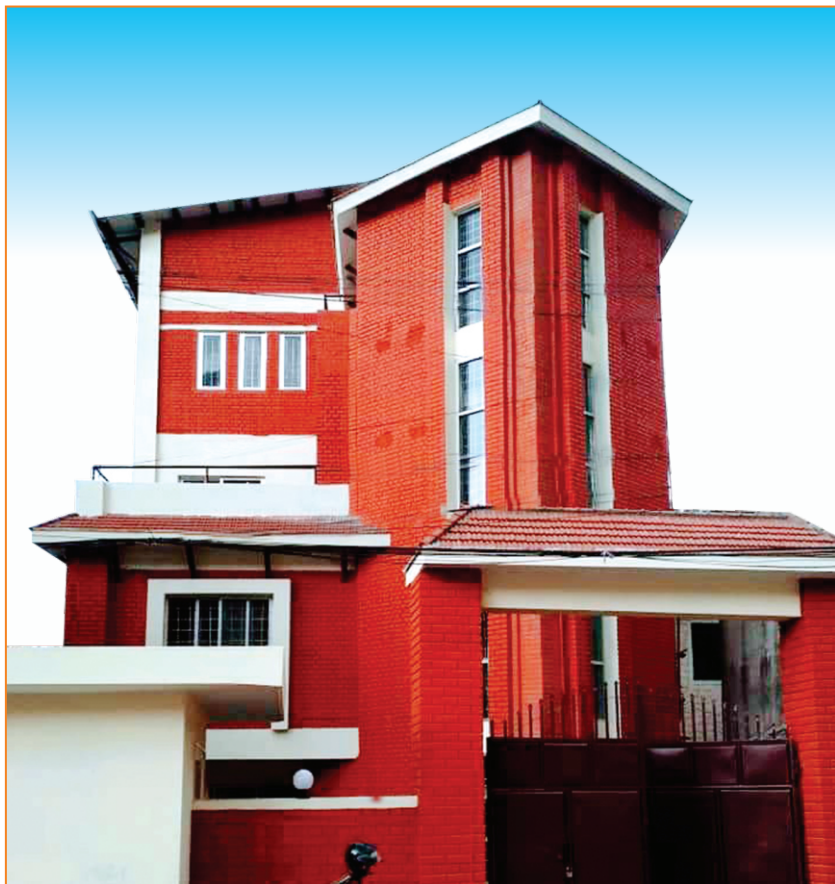
किरण पुस्तकालय भवन निर्माण अन्तिम चरणमा
